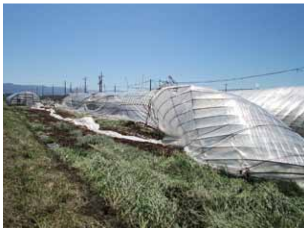
暴風により倒壊したハウス(彦根市)
